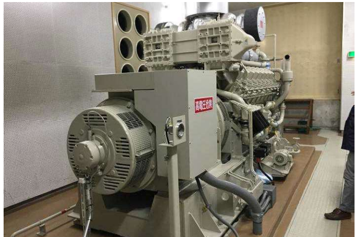
図3: パワーセンター内の1500kVAのディーゼル発電機
