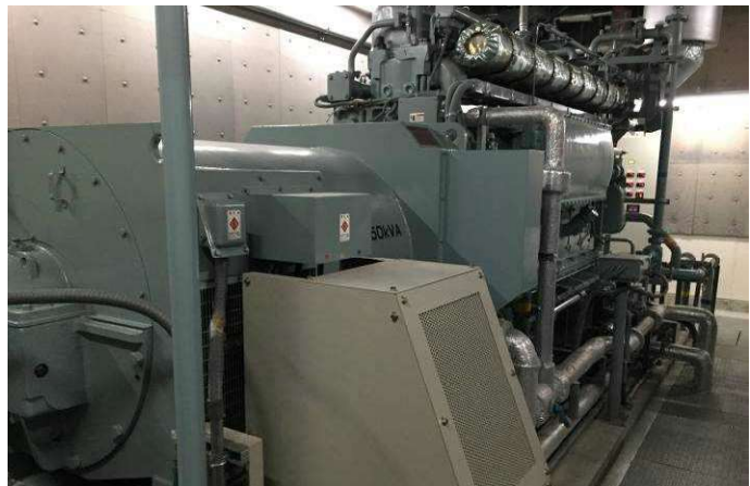
図4: 病棟機械室に設置された1250kVAのガスエンジン発電機
