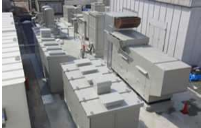
図2: パワーセンター脇に設置した2000kVAのハイブリッド発電設備
