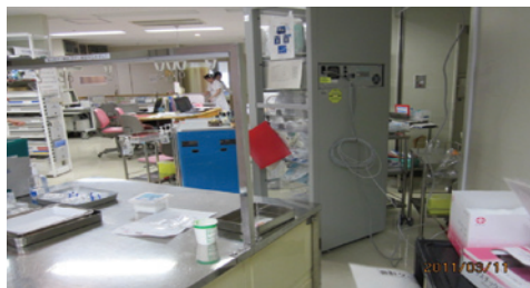
地震直後の病棟の様子(壁につけていた大型の電子キャビネットが1メートル以上も移動している)
